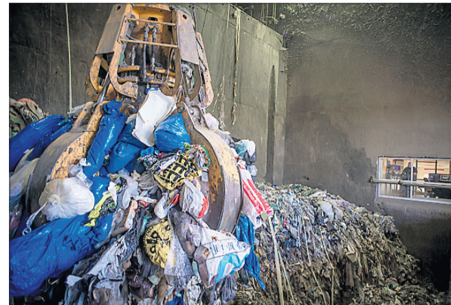
Aars Fjernvarme har nogle af Nordjyllands billigste priser, fordi man laver fjernvarme og el ved forbrænding af affald.
